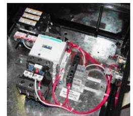
El **bastidor del control**, hecho de policarbonato duradero con una tapa traslúcida con bisagra, es a prueba de los elementos, polvo y roedores.
